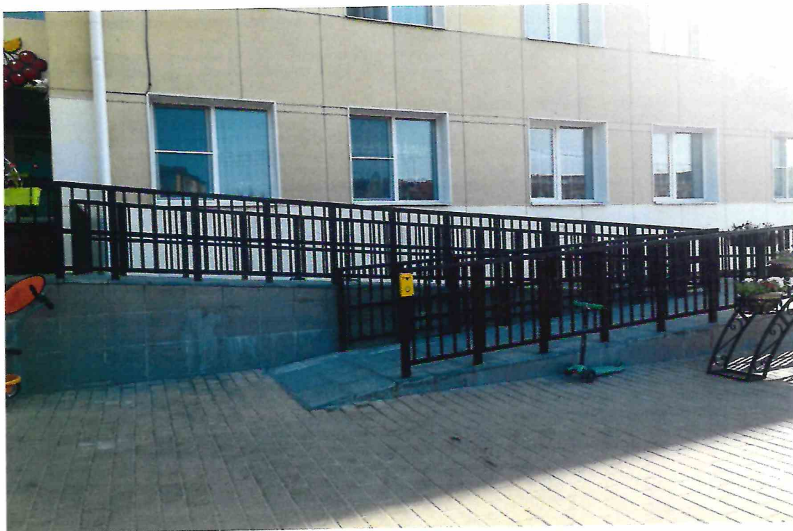
Главный вход, пандус
